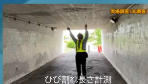
ひび割れ長さ計測
