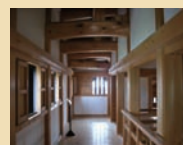
図-14 大洲城復元天守の内部
