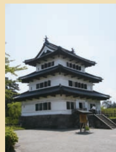
図-2 本丸側から見た現存天守 (著者撮影)
