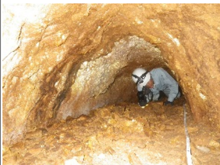
図4.空洞規模(直径約1m)
