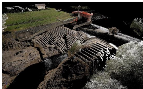
平成 23 年災で左岸側護岸工及び護床工の被災状況
