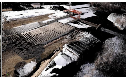
左岸側護岸工及び土砂吐一部洪水吐等の復旧状況
